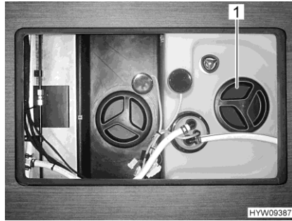
Fig. 220 Apertura per la pulizia (serbatoio dell'acqua)
