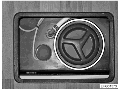
Bilde 162 Rengjøringsåpning (spillvannstank)
