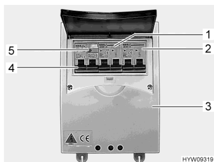
Obr. 106 Jistič vedení a proudový chránič (FI) (pojistková skříňka 230 V)
