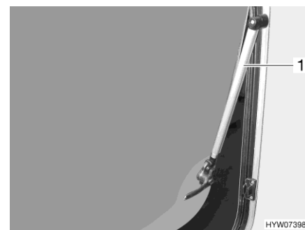
Bild 62 Överkantshängt fönster med automatik-spärr
