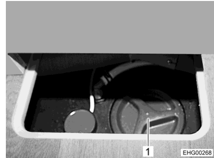
Fig. 142 Depósito de aguas residuales
