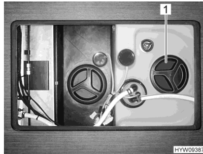
Obr. 220 Čisticí otvor (nádrž na vodu)
