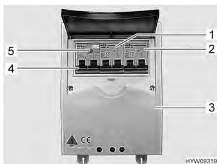
Bild 66 Leitungsschutzschalter und FI-Schalter (230-V-Sicherungskasten)
