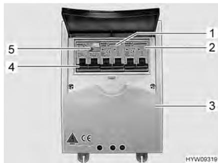
Fig. 66 Interruptor de protección de línea e interruptor FI (caja de fusibles de 230 V)
