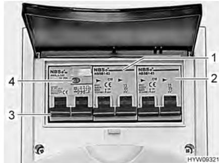
Fig. 70 Interruptor de protección de línea e interruptor FI (caja de fusibles de 230 V)
