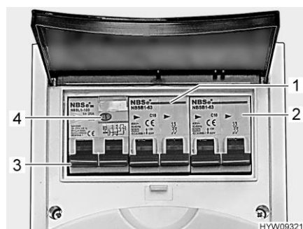
Kuva 74 Johdinsuojakytkimet ja FI-kytkin (230 V:n sulakerasia)
