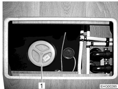
Bilde 117 Rengjøringsåpning (spillvannstank)
