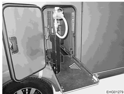
Kuva 130 Kaasupullokotelon alusta vaihtoasennossa
