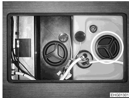
Obr. 219 Čisticí otvor (nádrž na vodu)
