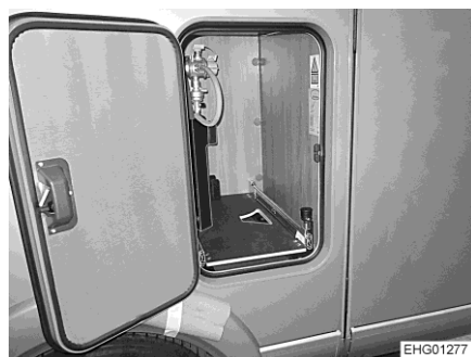
Obr. 128 Zásuvka plynové skříně
