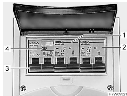
Bilde 108 Ledningsbeskyttelsesbryter og FI-bryter (230 V-sikringsboks)
