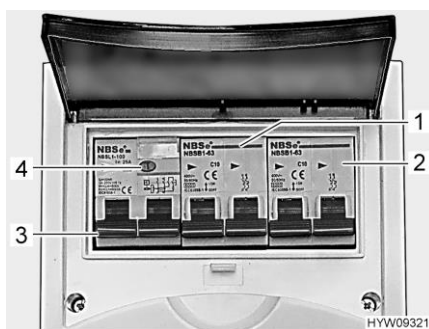
Afb. 145 Ledningsskyddsbrytare och FI-brytare (230 V-säkringslåda)
