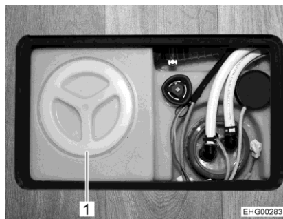
Bild 116 Reinigungsoffnung (Wassertank)
