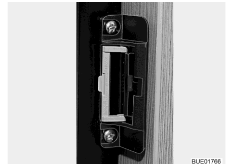
Bilde 152 Låseanordning (luftestilling)
