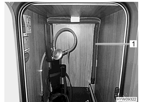
Fig. 160 Tuyau d'évacuation des eaux usées (extension du compartiment à gaz)
