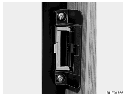
Fig. 94 Dispositif de fermeture (position de ventilation)
