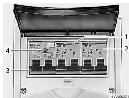
Fig. 74 Disjoncteur de protection de circuit et disjoncteur FI (coffret de fusibles 230 V)
