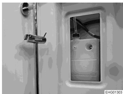
Rys. 222 Zbiornik wyrównawczy (ogrzewanie wody)
