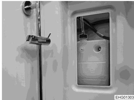
Bild 222 Ausgleichsbehälter (Warmwasser-Heizung)
