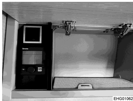
Bild 83 Bedienteile im Dachstauschrank (Beispiel)
