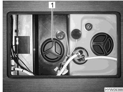
Fig. 210 Orificio de limpieza (depósito de aguas residuales)
