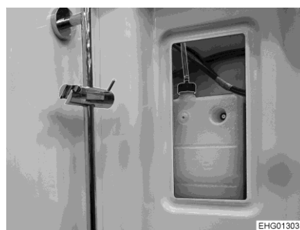
Fig. 222 Vase d'expansion (chauffage à eau chaude)
