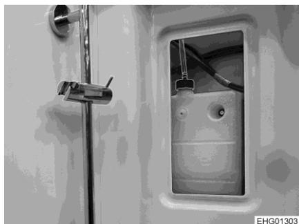
Bild 222 Ausgleichsbehälter (Warmwasser-Heizung)
