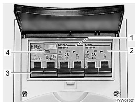
Bild 160 Ledningsskyddsbrytare och jordfelsbrytare (230 V-säkringslåda)
