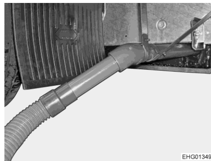
Bilde 209 Avløpsrør med spillvannsslange
