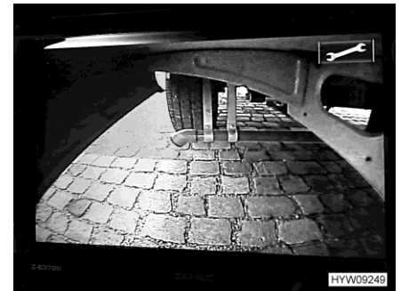
Bilde 21 Bilde fra kamera for spillvannstank (eksempel)
