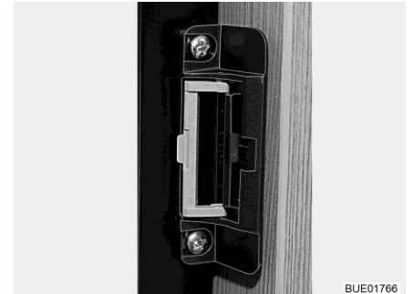
Bild 146 Verschlusseinrichtung (Lüftungsstellung)
