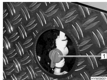
Bild 129 Vorlaufventil (Beheizung Heckgarage)
