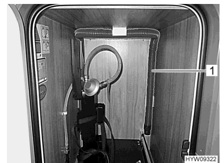
Rys. 143 Wąż odprowadzający ścieki (wyciągana skrzynia na butle gazowe)
