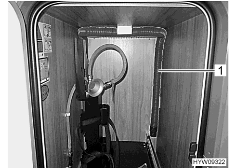
Kuva 130 Jätevesiletku (kaasupullokotelon alusta)
