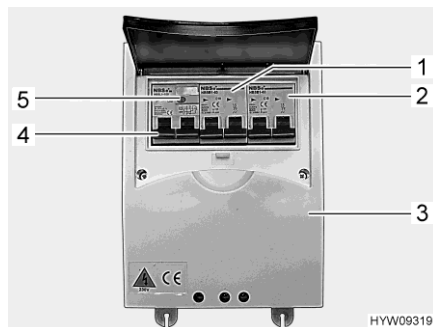
Fig. 74 Interruptor de protección de línea e interruptor FI (caja de fusibles de 230 V)
