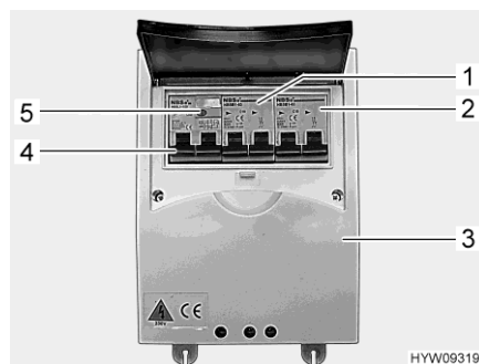
Bild 142 Leitungsschutzschalter und FI-Schalter (230-V-Sicherungskasten)
