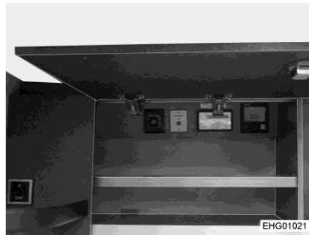
Kuva 117 Yläkaapistossa olevat ohjainlaitteet
