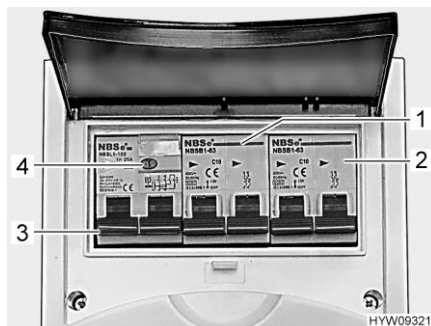
Bild 81 Ledningsskyddsbrytare och jordfelsbrytare (FI) (230 V-säkringslåda)
