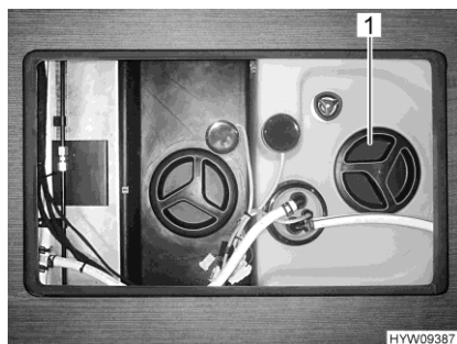
Fig. 209 Ouverture de nettoyage (réservoir d'eau)
