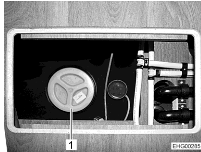
Obr. 134 Čisticí otvor (nádrž na odpadní vodu)
