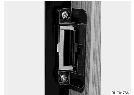
Bild 136 Låsanordning (ventilationsläge)
