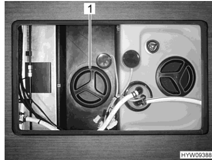
Fig. 221 Orificio de limpieza (depósito de aguas residuales)
