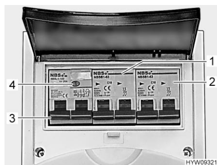
Fig. 81 Interruttore di sicurezza e interruttore di sicurezza per correnti di guasto (FI) (scatola dei fusibili a 230 V)
