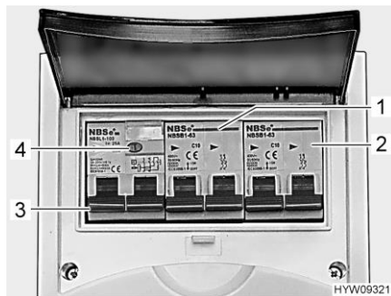
Fig. 106 Interruttore di sicurezza e interruttore automatico FI (scatola dei fusibili a 230 V)
