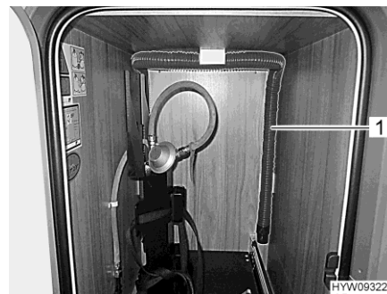
Fig. 154 Tuyau d'évacuation des eaux usées (extension du compartiment à gaz)
