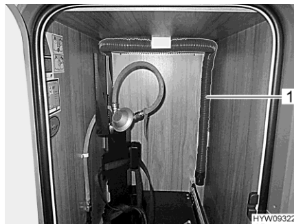
Fig. 154 Manguera de aguas residuales (dispositivo de extracción de caja para bombonas de gas)
