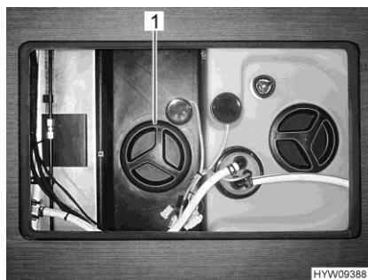
Fig. 209 Orificio de limpieza (depósito de aguas residuales)
