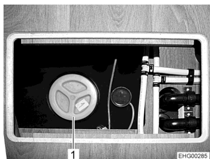
Fig. 117 Orificio de limpieza (depósito de aguas residuales)
