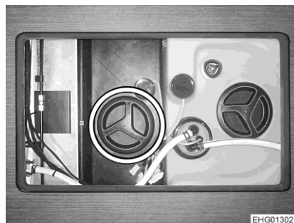
Obr. 220 Čistící otvor (nádrž na odpadní vodu)
