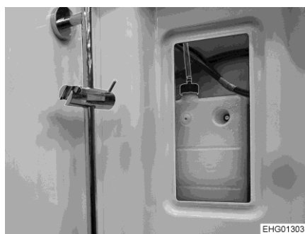
Obr. 222 Expanzní nádoba (teplovodní topení)
