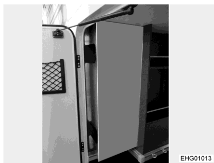
Rys. 104 Miejsce instalacji inwertera
