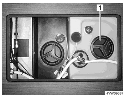
Fig. 208 Ouverture de nettoyage (réservoir d'eau)
